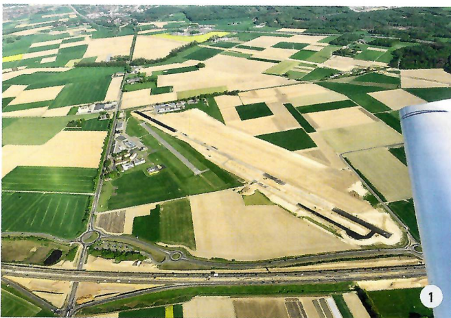
1: Aachen Merzbrück mit der alten Bahn und der im Bau befindlichen neuen Bahn, Blick von Westen; Foto von April 2020 (c) Tiemo Benjamin Esser
